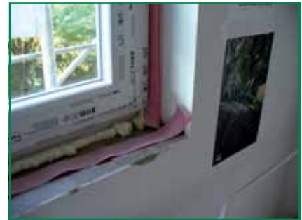
Obr. 18: Použitie parotesniacej pásky v pripojovacej škáre z interiéru
